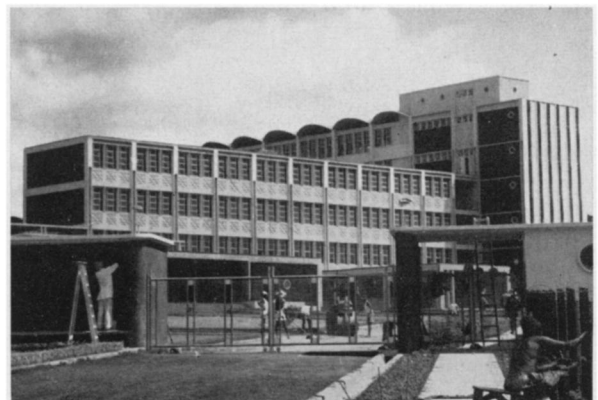
Bild 6: Zentralkrankenhaus von Kumasi (vgl. Abb. 2)
